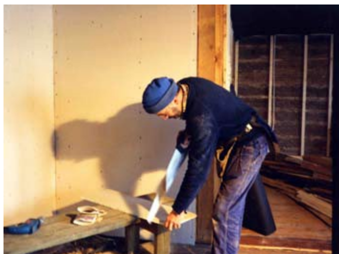
Byggnadsarbetet leddes av Lars-Erik. Till sin hjälp hade han två praktikanter; Marenco och Michael.
