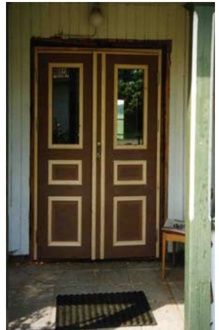
Den otidsenligaytterdörren byttes mot en specialbyggd dubbeldörr.
